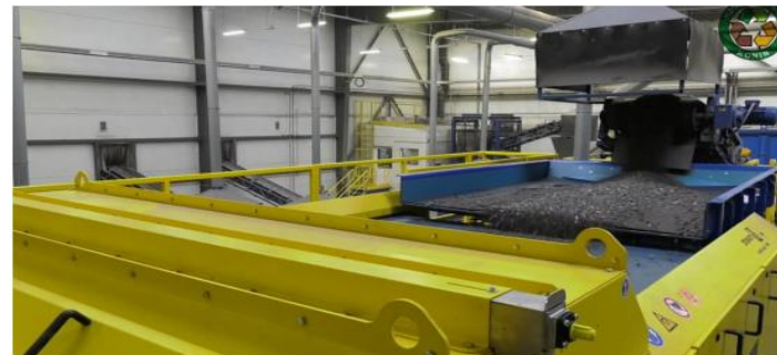
Montaż separatora wiropędowego
